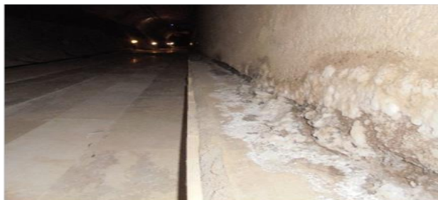
Расми 4. -Вайроншавии сатҳи бетонҳо дар қисматҳои девор ва сакфи нақби №3.
