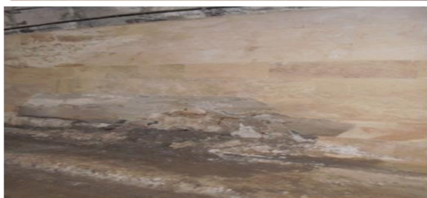
Расми 4. -Вайроншавии сатҳи бетонҳо дар қисматҳои девор ва сакфи нақби №3.
