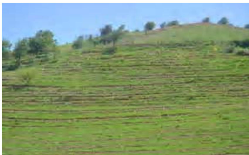
Фото 3. Строительство узкополосчатого терраса на крутых склонах ручным способом, долина реки Алмоси Гиссарского района
