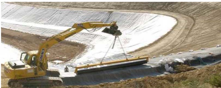
Расми 4. - Корҳои гидроизолатсионии зиддиполоиш дар иншооти гидротехникӣ бо усули геомембранаҳои тамғаи «Славрос»
